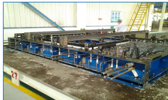
内页板钢筋、管线铺设
