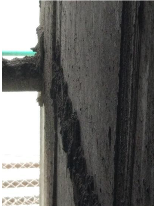
温度缝双墙处灌浆封堵
