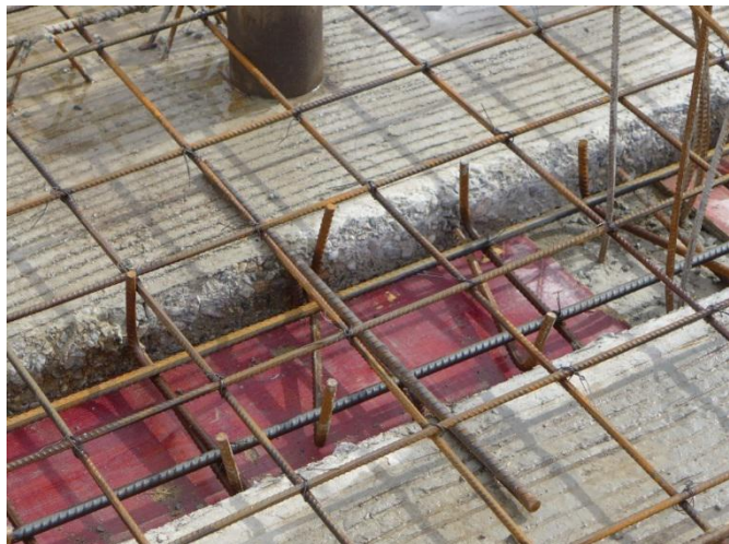
后浇部位钢筋碰撞
