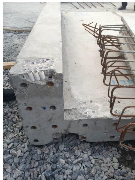
注浆管和出浆管布置问题
