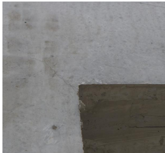
门窗洞口边蒸养裂缝
