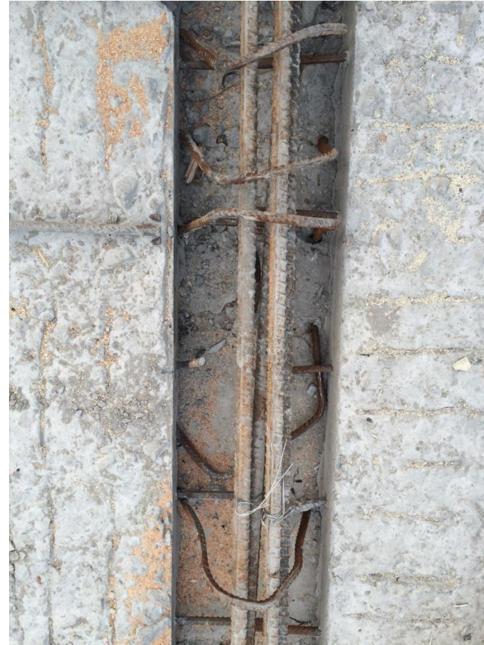
构件安装精度问题
