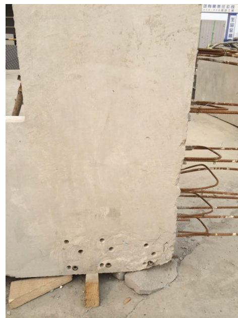
注浆管和出浆管布置问题
