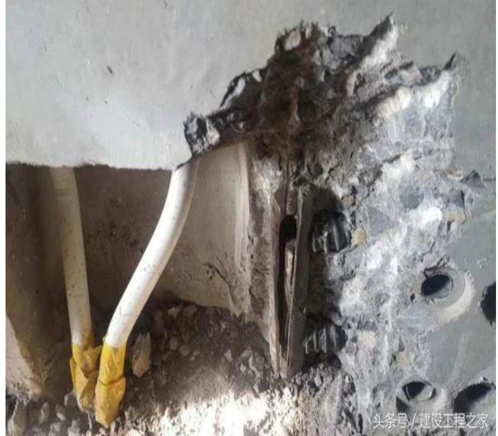
线盒处灌浆封堵
