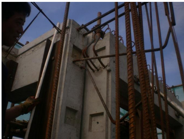
后浇部位钢筋碰撞
