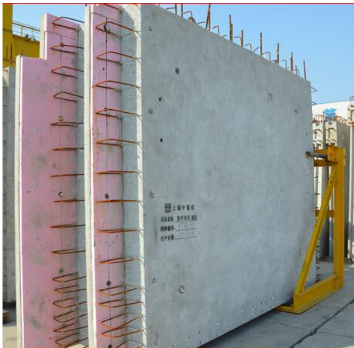
预制夹心保温剪力墙
