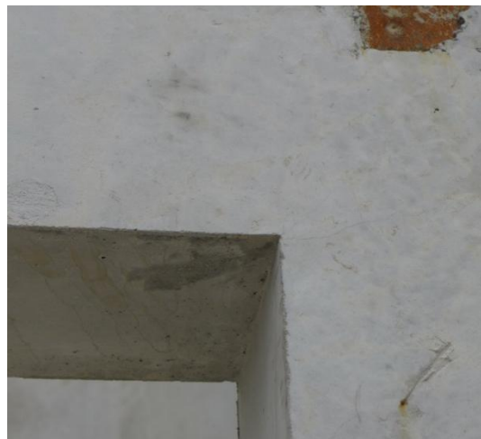
门窗洞口边蒸养裂缝
