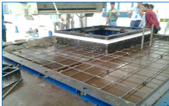
外页板钢筋铺设
