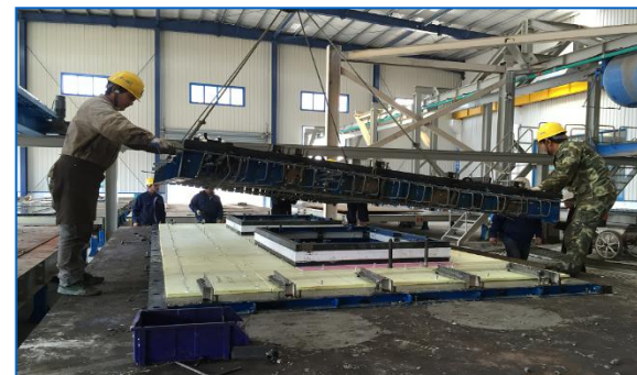
内页板模板安装
