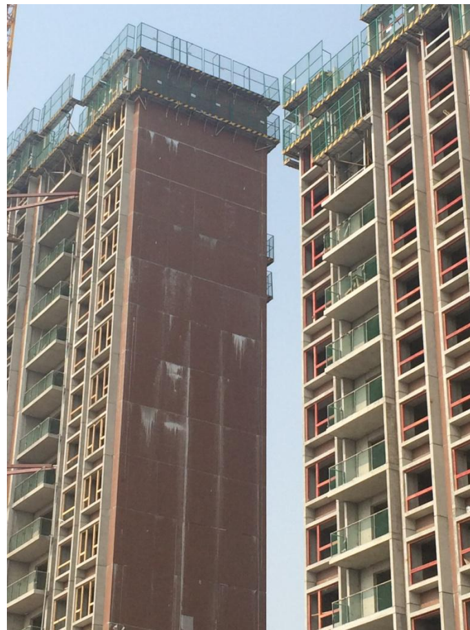
外墙板接缝漏浆问题
