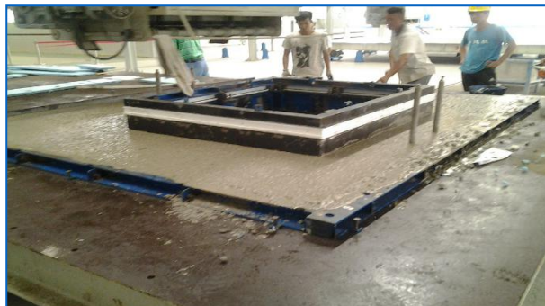
外页板混凝土浇筑
