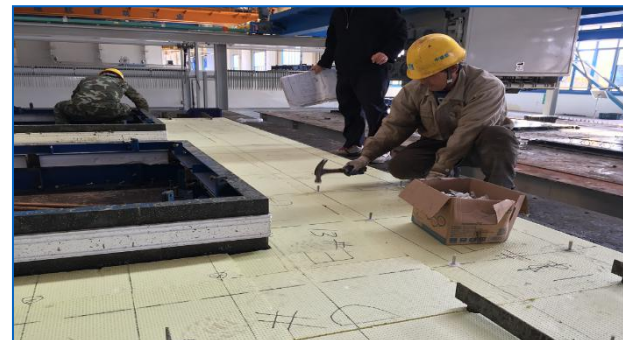
保温层、连接件安装
