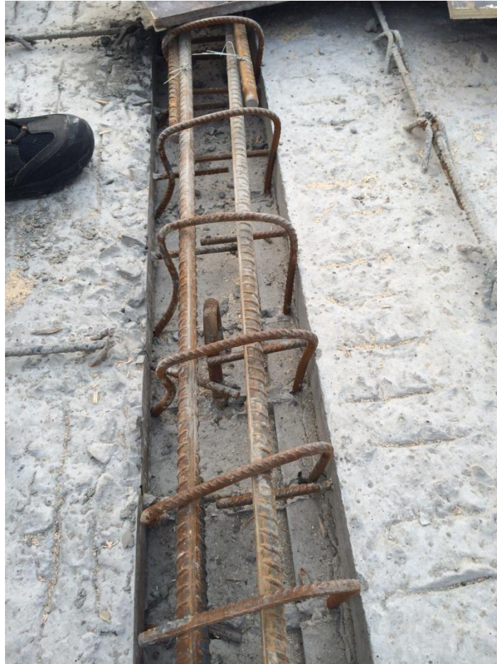
构件安装精度问题
