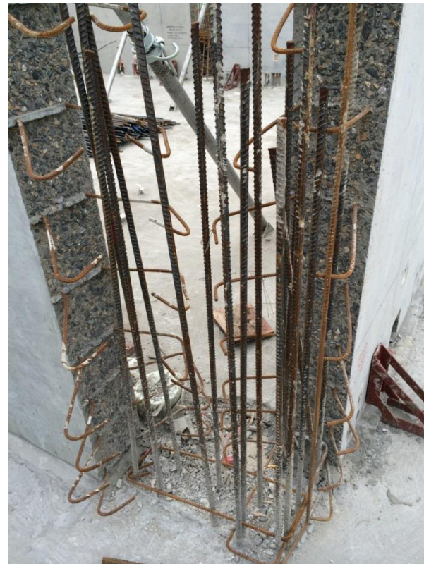
后浇部位钢筋碰撞
