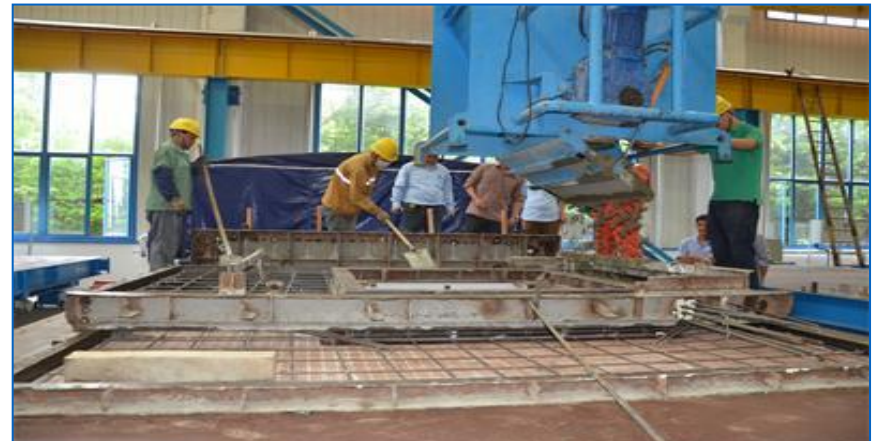
混凝土浇筑
