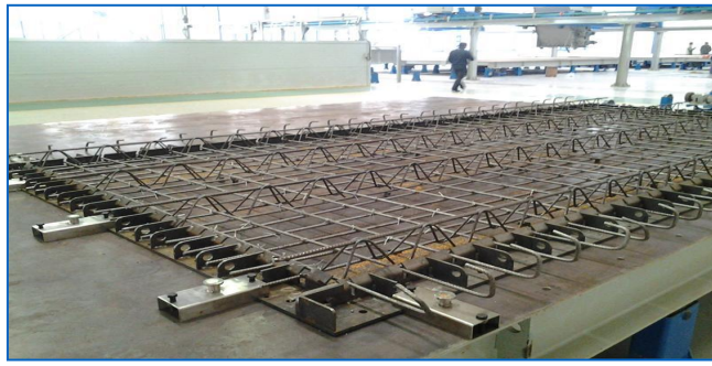
钢筋笼、预埋件安装
