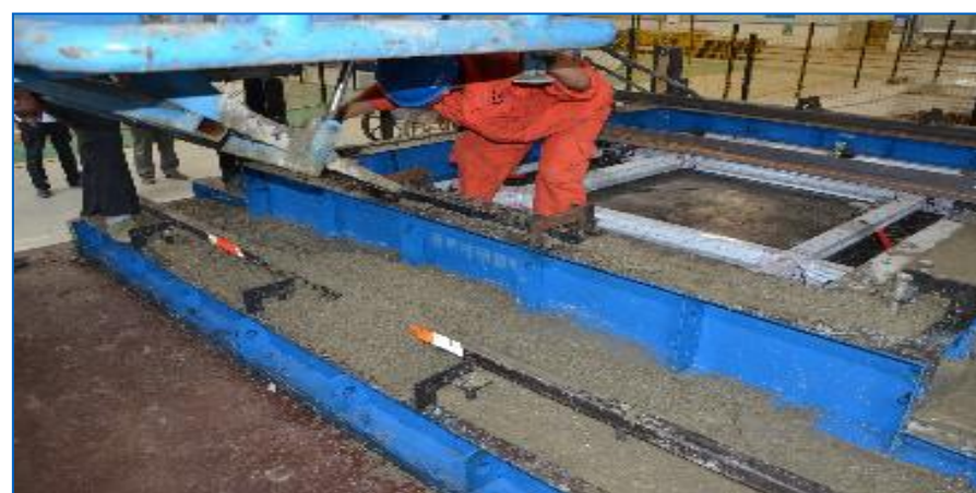
混凝土浇筑
