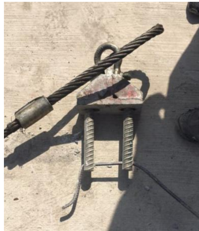
构件吊运埋件拔出
